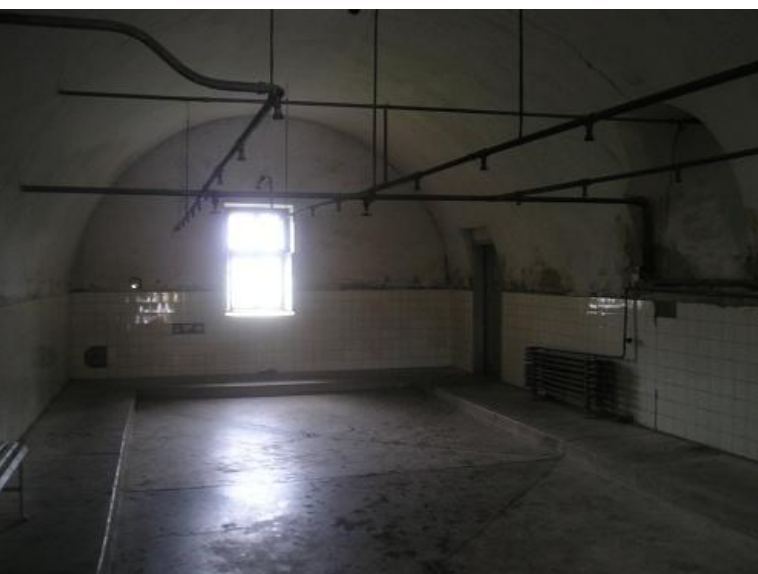
Malá pevnost Terezín, věznice služebny gestapa v Praze. I. dvůr (LCH2013)
