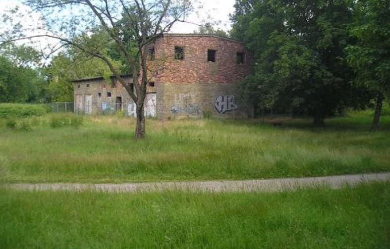
Bývalá trafostanice a vodárna pracovního tábora Falkensee, Německo.
