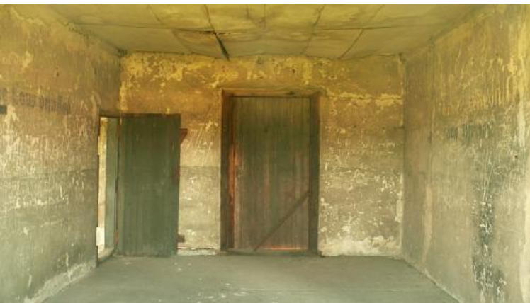
Koncentrační tábor Auschwitz II-Birkenau (Oświęcim-Brzezinka), Polsko, sekce BIa, Frauenlager, desinfekce, sprchy. Na stropě je stále vidět původní kartonové obložení, kterým byly obloženy rovněž stropnice všech obytných baráků. (LCH2016)
