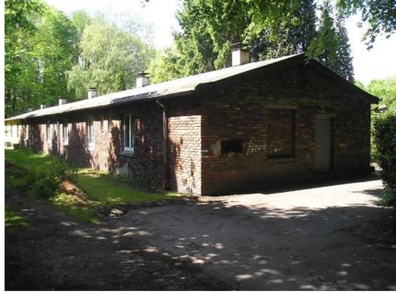
Bývalý pracovní tábor na šachtě Zeche Vereinigte Constantin der Grosse, Bergen, Bochum, Německo, Ubytováno zde bylo 600 mužů z Polska a Haliče, nasazených v důlní těžbě. (LCH2014)
