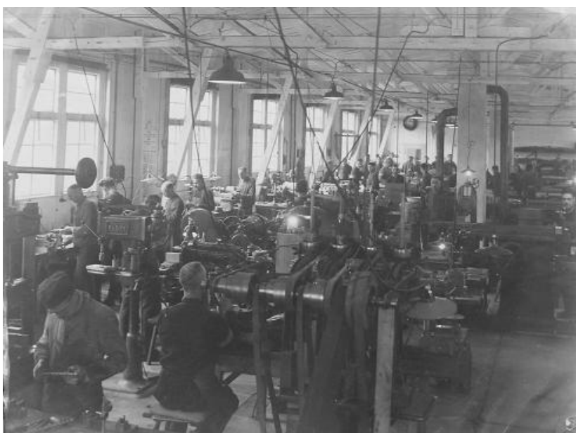
Dilenské baráky firmy GWF v Gräfentonně
