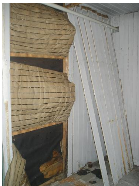
Pracovní tábor Wernigerhode, Německo, pobočka KZ Buchenwald, Na fotografii výše ubikace vězňů. Fotografie níže nám umožňuje nahlédnout do konstrukce obytných baráků. Prostor mezi vnitřním a vnějším dřevěným obložním byl vyplněn dřevitou vatou. Na vnější straně byla přibita lepenka. (LCH2014)
