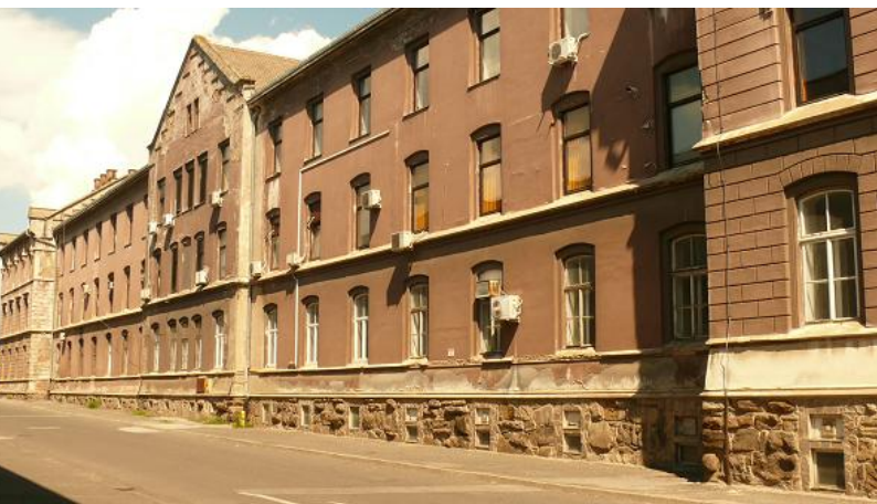
Objekt bývalých domobraneckých kasáren v Melju, Maribor, Slovinsko (LCH2016)
