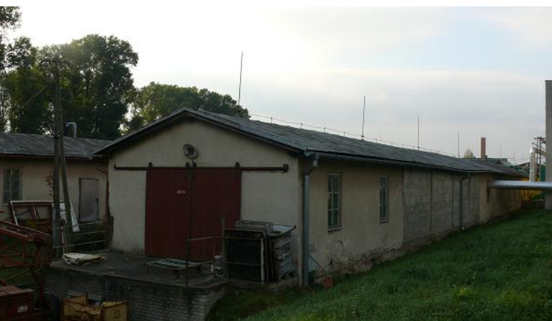
Detail na jednu ze stěn objektu bývalých dílen prozrazuje mnohé o konstrukci objektů zřízených v táboře od roku 1942. Jednalo se o dřevěné konstrukce s obvodovými stěnami z Heraklitu, náhražkového stavebního materiálu, na zděné podezdívce. (LCH2015)
