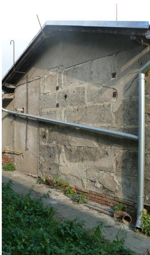
Detail na jednu ze stěn objektu bývalých dílen prozrazuje mnohé o konstrukci objektů zřízených v táboře od roku 1942. Jednalo se o dřevěné konstrukce s obvodovými stěnami z Heraklitu, náhražkového stavebního materiálu, na zděné podezdívce. (LCH2015)
