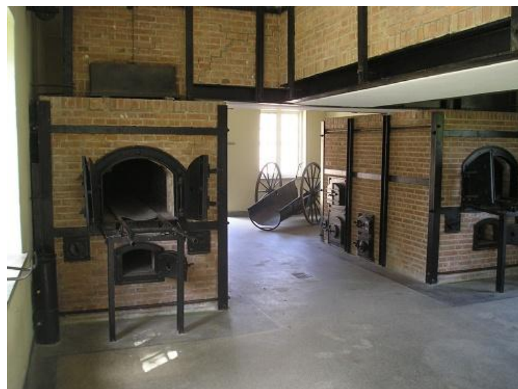
Koncentrační tábor Herzogenbusch, Holandsko, krematorium. Zpočátku bylo využíváno mobilní ocelové pece s šamotovou vyzdívkou na mazut. Později byly postaveny dvě zděné pece na uhlí. (LCH2013)
