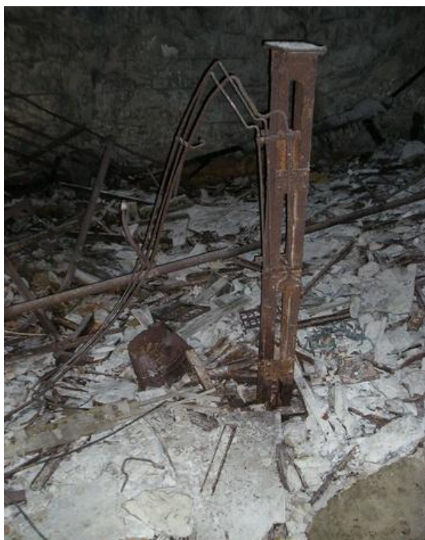
Podzemní továrna Mittelwerk u Nordhausenu, Německo. Jeden z opěrných pilířů, na které byly kladeny železobetonové desky, dělicí štoly do několika podlaží. Každá z bočních štol měla dle potřeby až 3 patra. (LCH2013)
