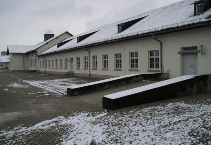
Koncentrační tábor Dachau, Německo, hospodářská budova, Budova postavena v letech 1937/38. Nacházela se zde táborová kuchyně, sklady potravin, oblečení, umyvárna, dílny a kanceláře (LCH2013)
